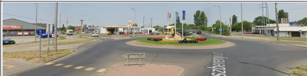
A 311. sz. főút és a Malomtó szél körforgalma, környezetében kereskedelmi-szolgáltató gazdasági területek vannak
