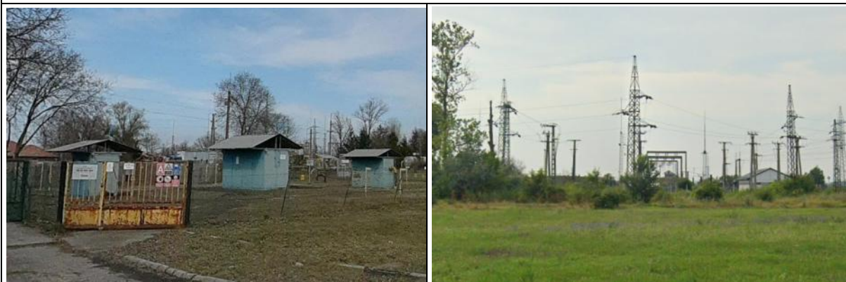
Közmű telephelyek: gázfogyasztó és transzformátor állomás
