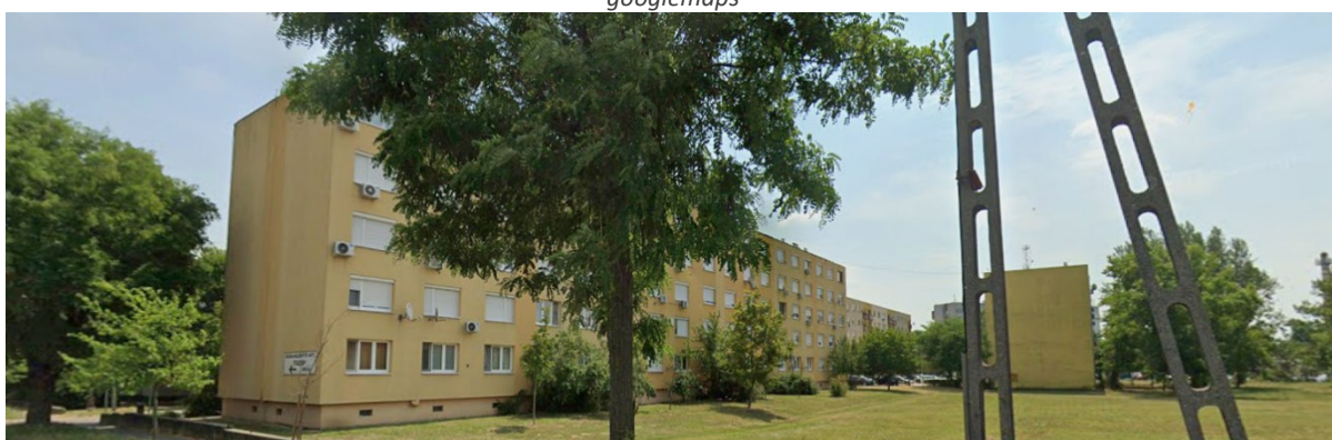
Szolnoki úti épületek googlemaps
